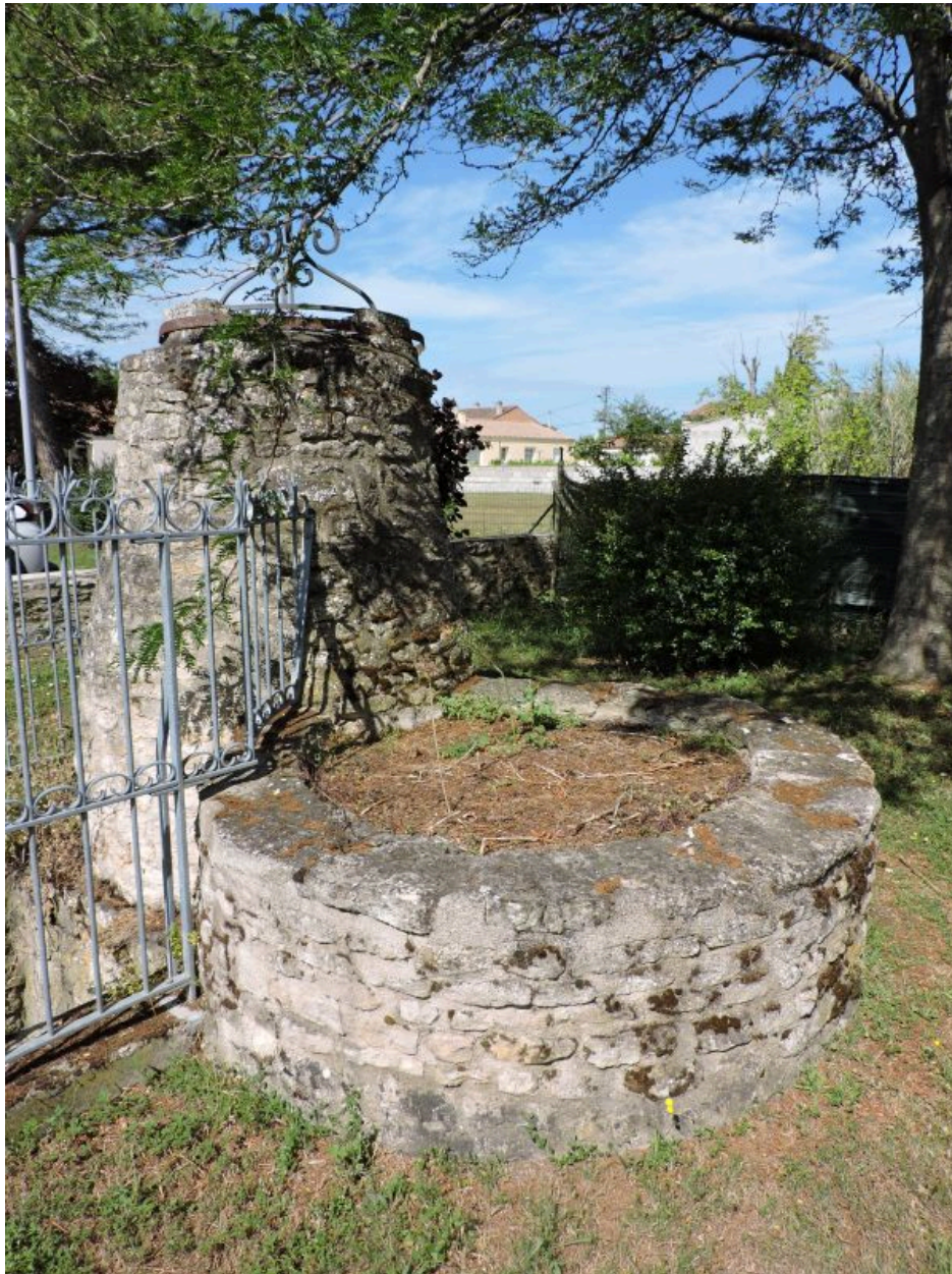
Le puits et l'abreuvoir vus depuis l'est.
