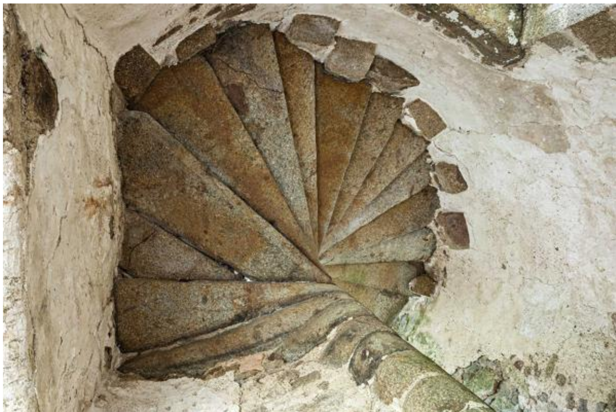
Escalier du corps de logis sud.
