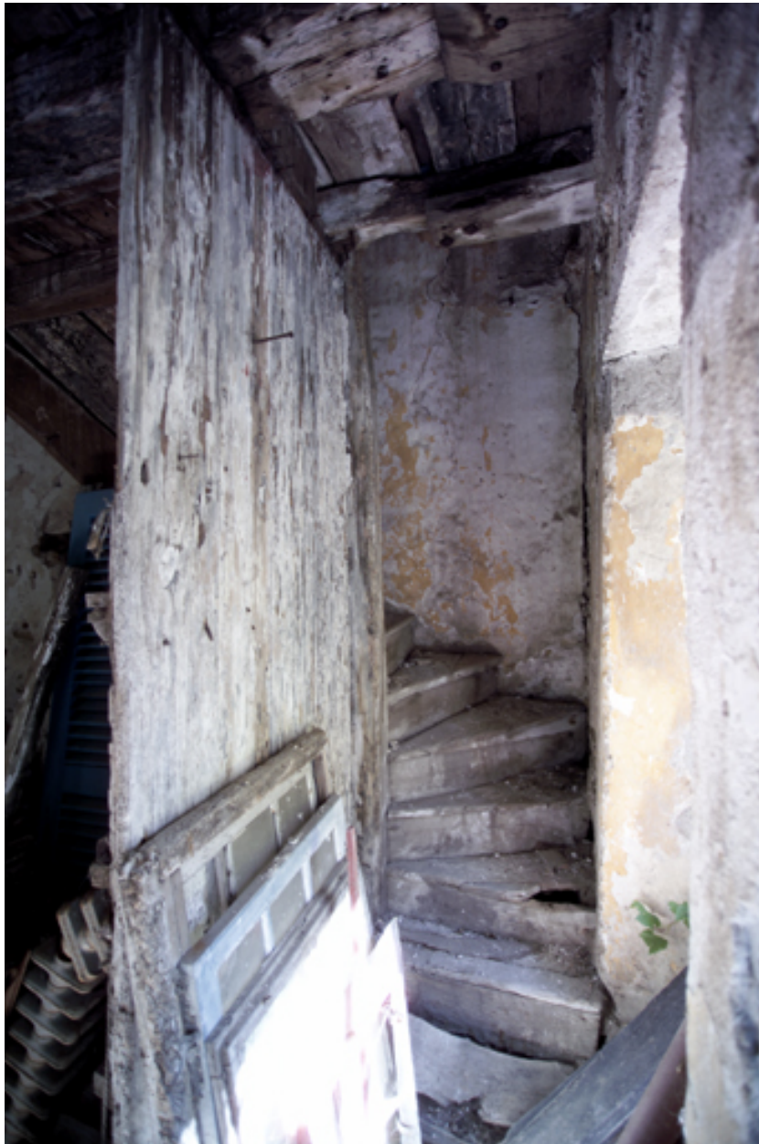
L'escalier contre le pignon est.
