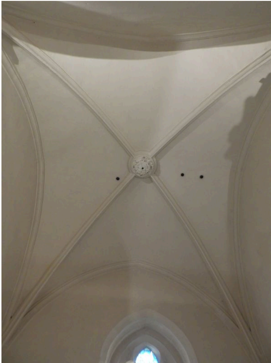
La voûte de la chapelle latérale nord.
