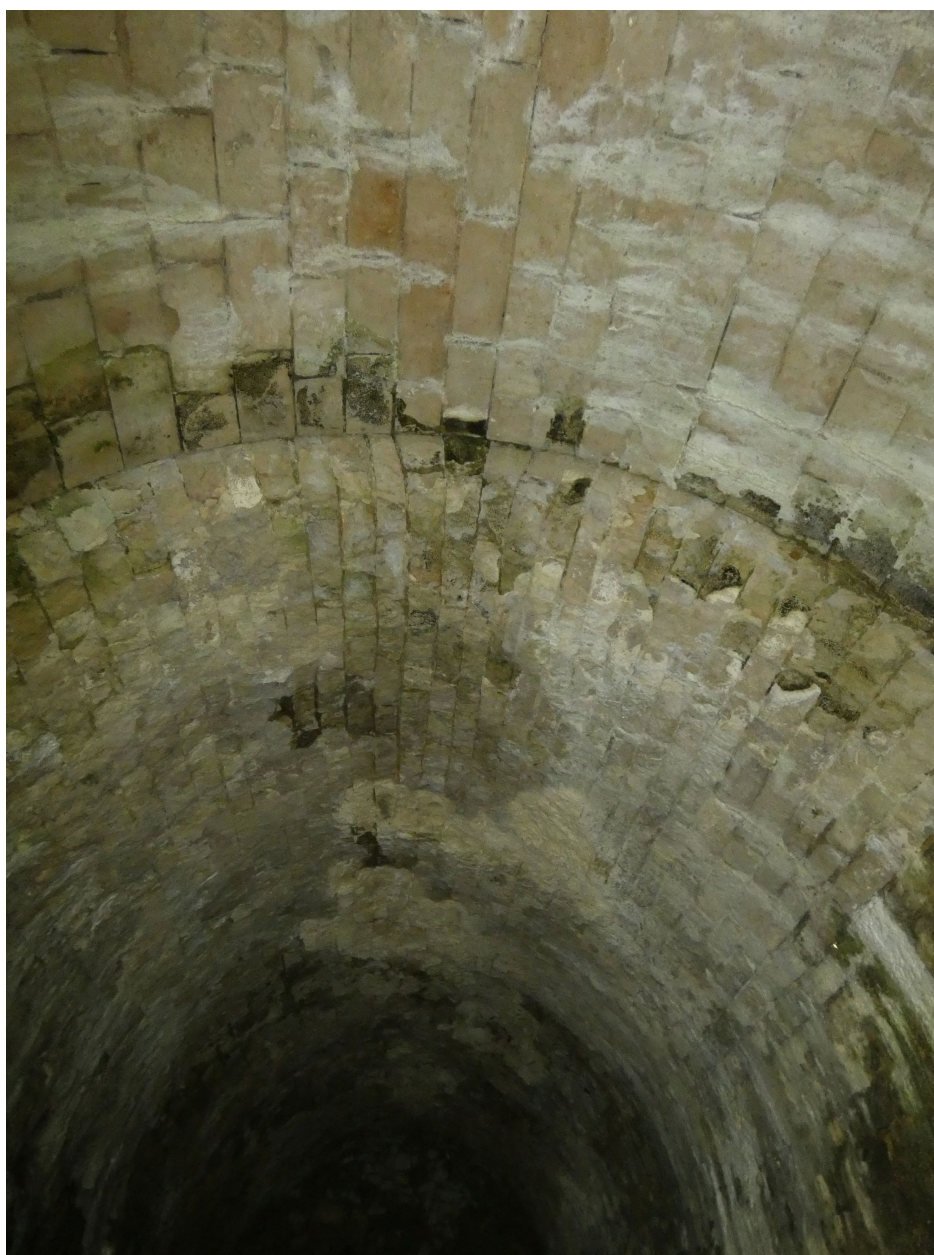
La voûte du tunnel.
