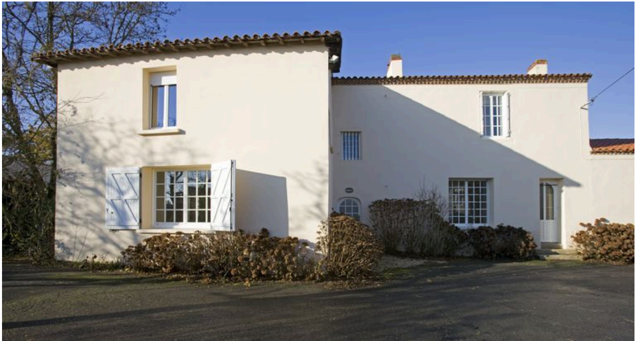
Le logis. Façade est, partie sud.
