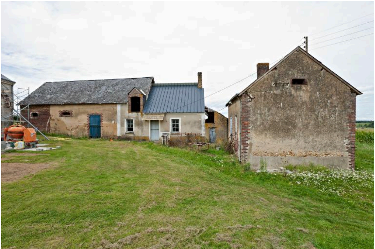
Vue prise depuis le sud : façade antérieure de l'ensemble 1 et mur-pignon de la maison 2.
