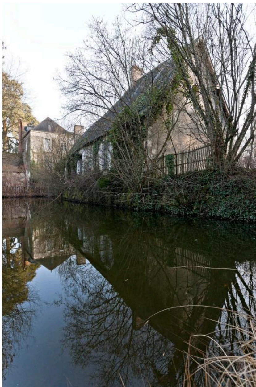
Douve à l'arrière de la dépendance 1.
