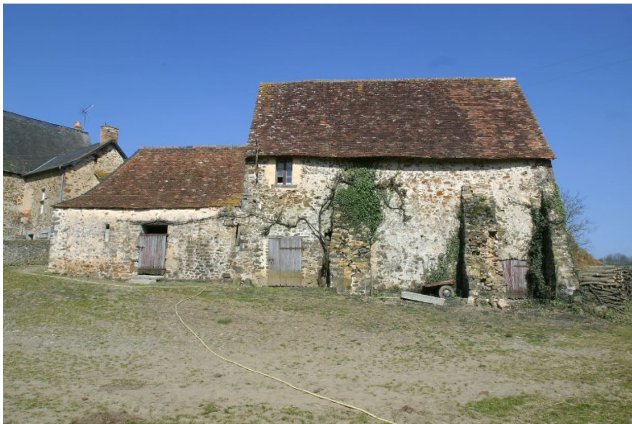
La chapelle. Elévation sud.
