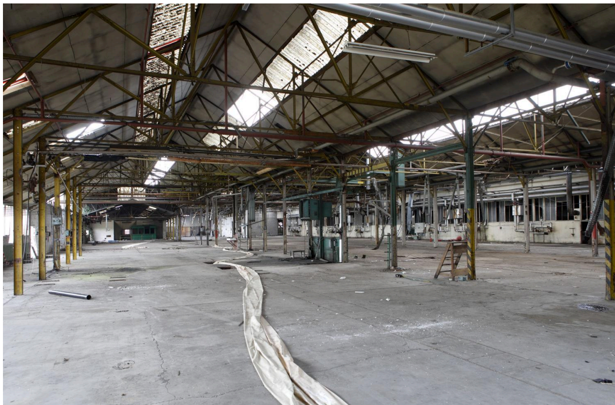
Bâtiment de production à structure métallique, 1950-1960.
