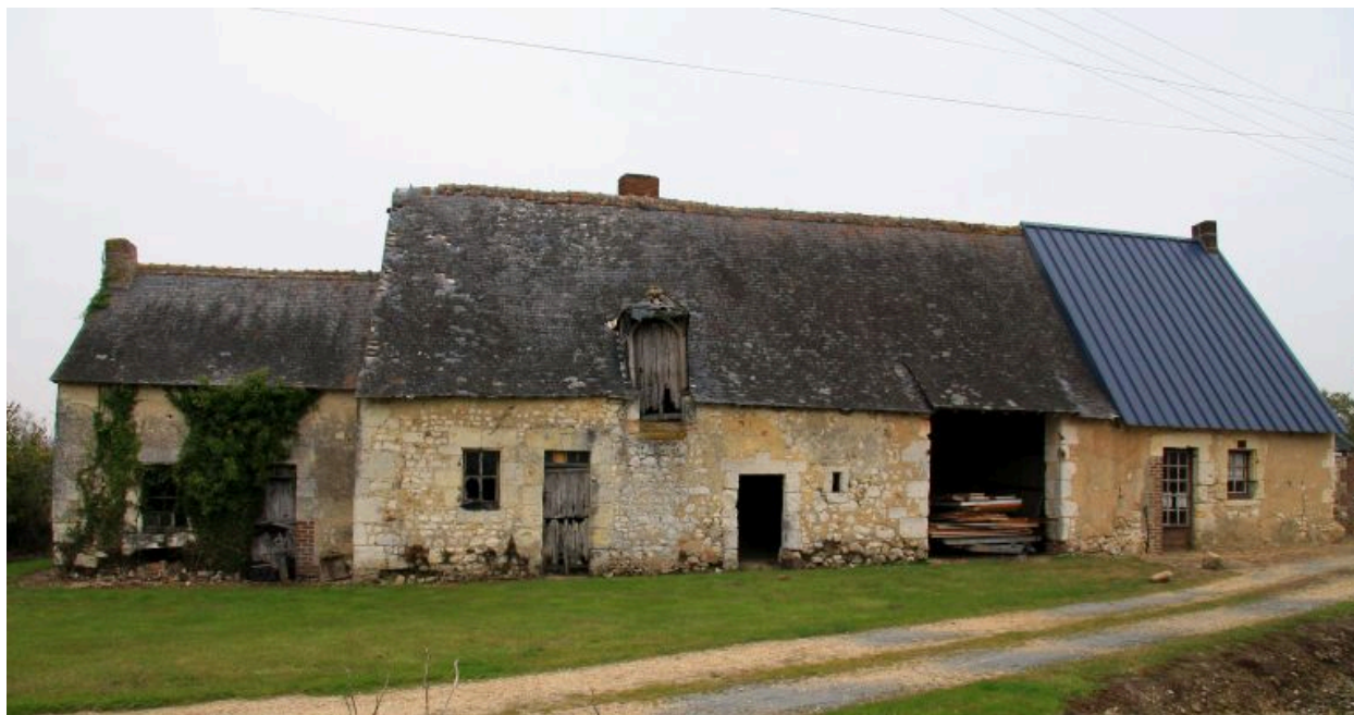
Maison 1 : façade antérieure.
