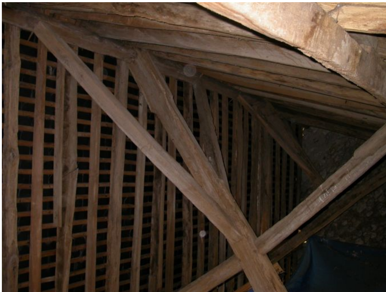
La grange : la charpente.
