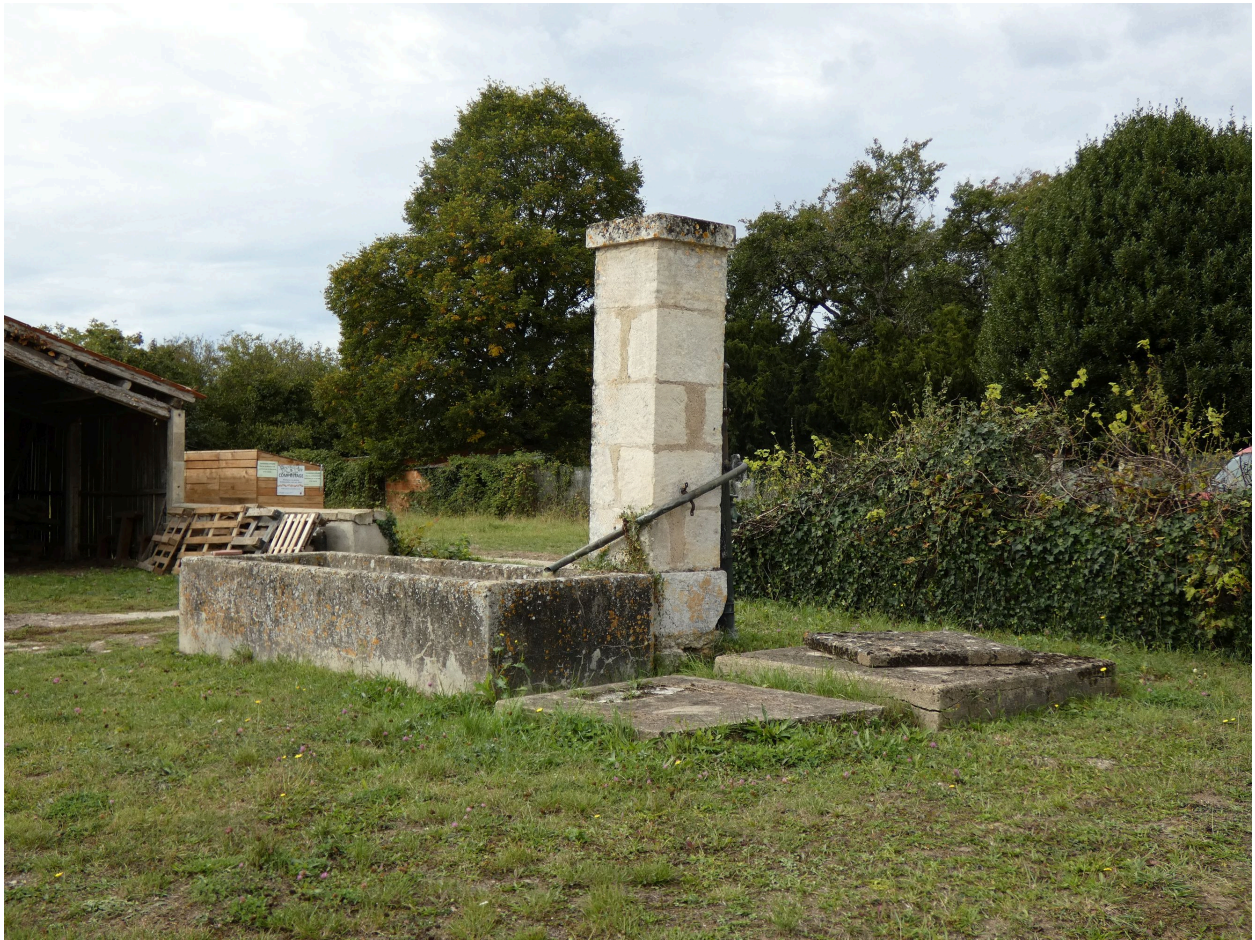
Le puits et son timbre, à l'ouest de la cour, vus depuis le nord-est.
