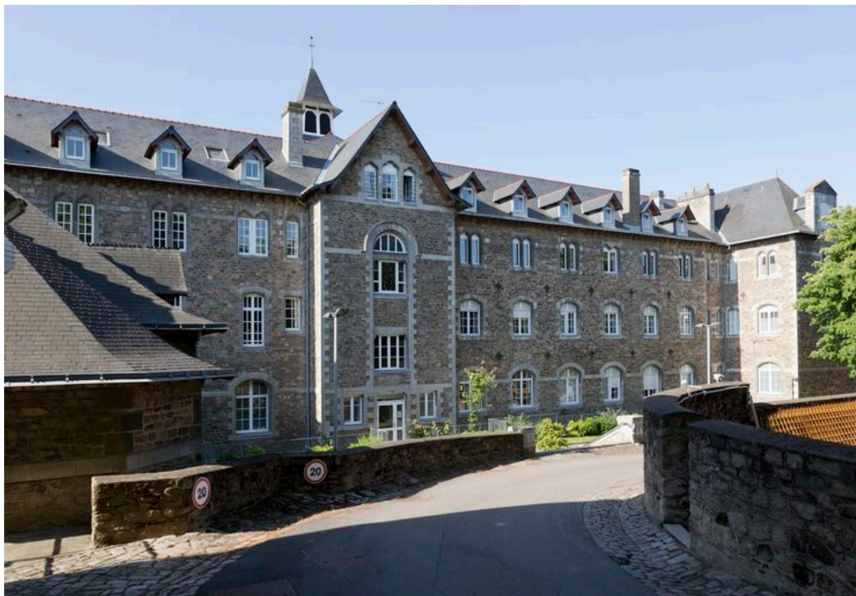
3 : bâtiment de la communauté, façade nord.
