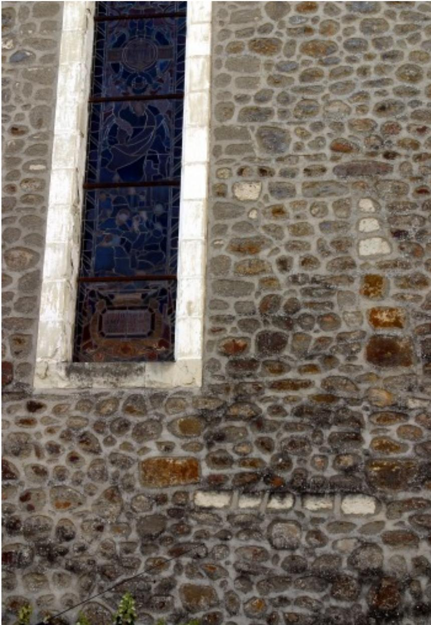
Détail de l'élévation nord : fenêtre bouchée.
