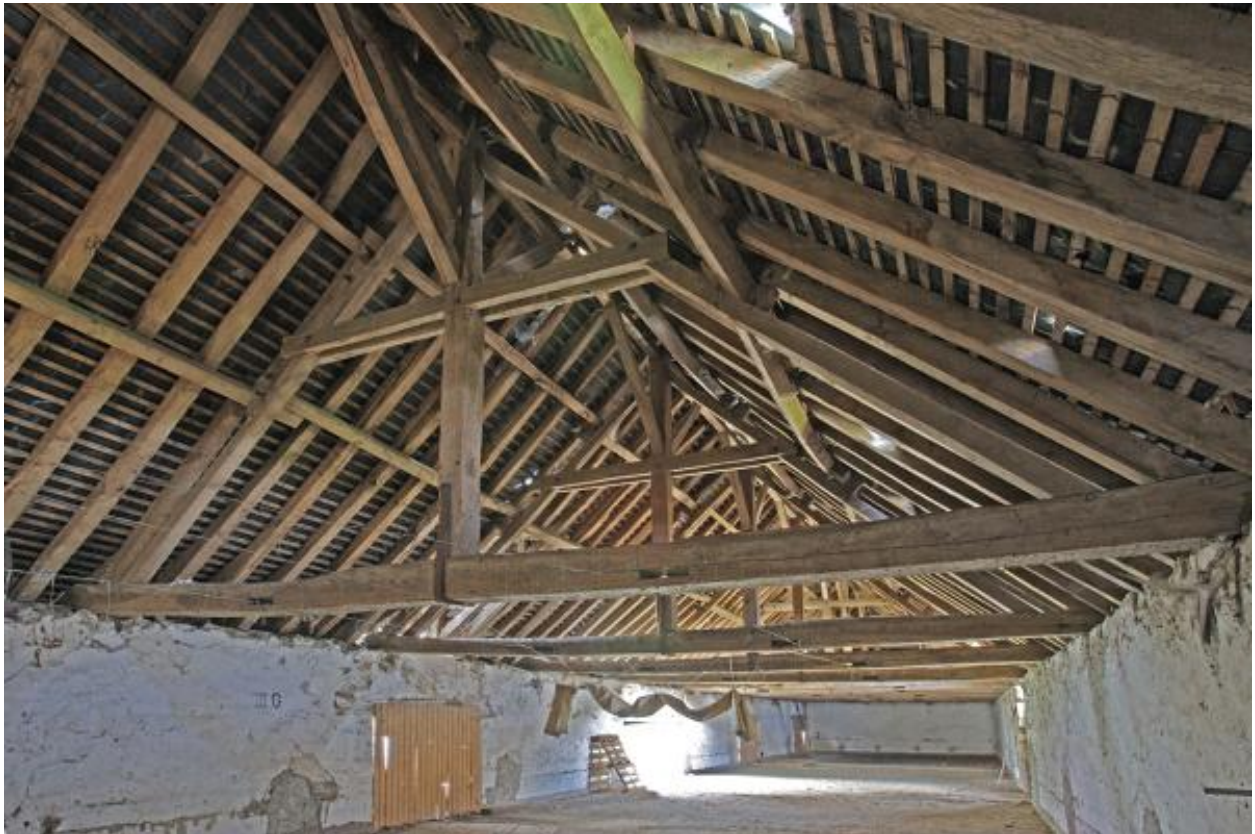
L'aile de commons nord, charpente.
