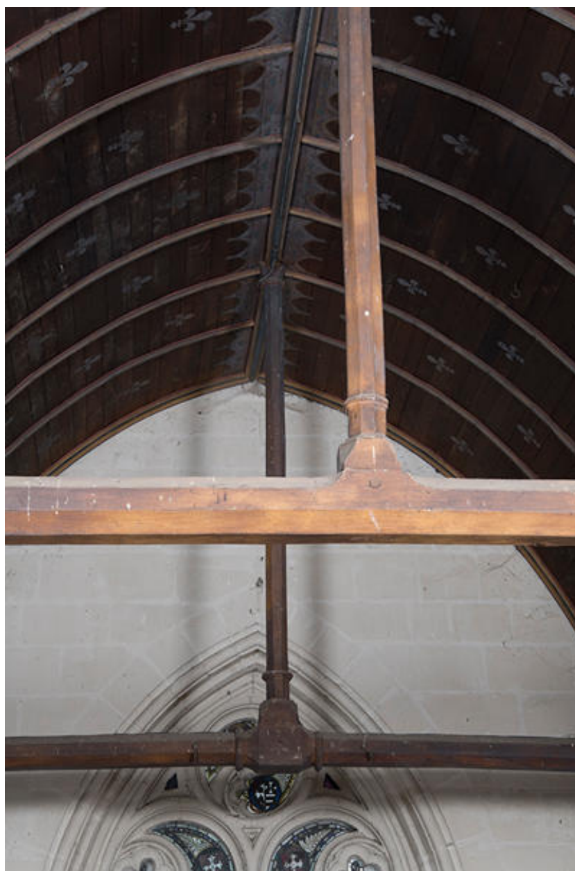
Choeur. Détail de la charpente lambrissée.
