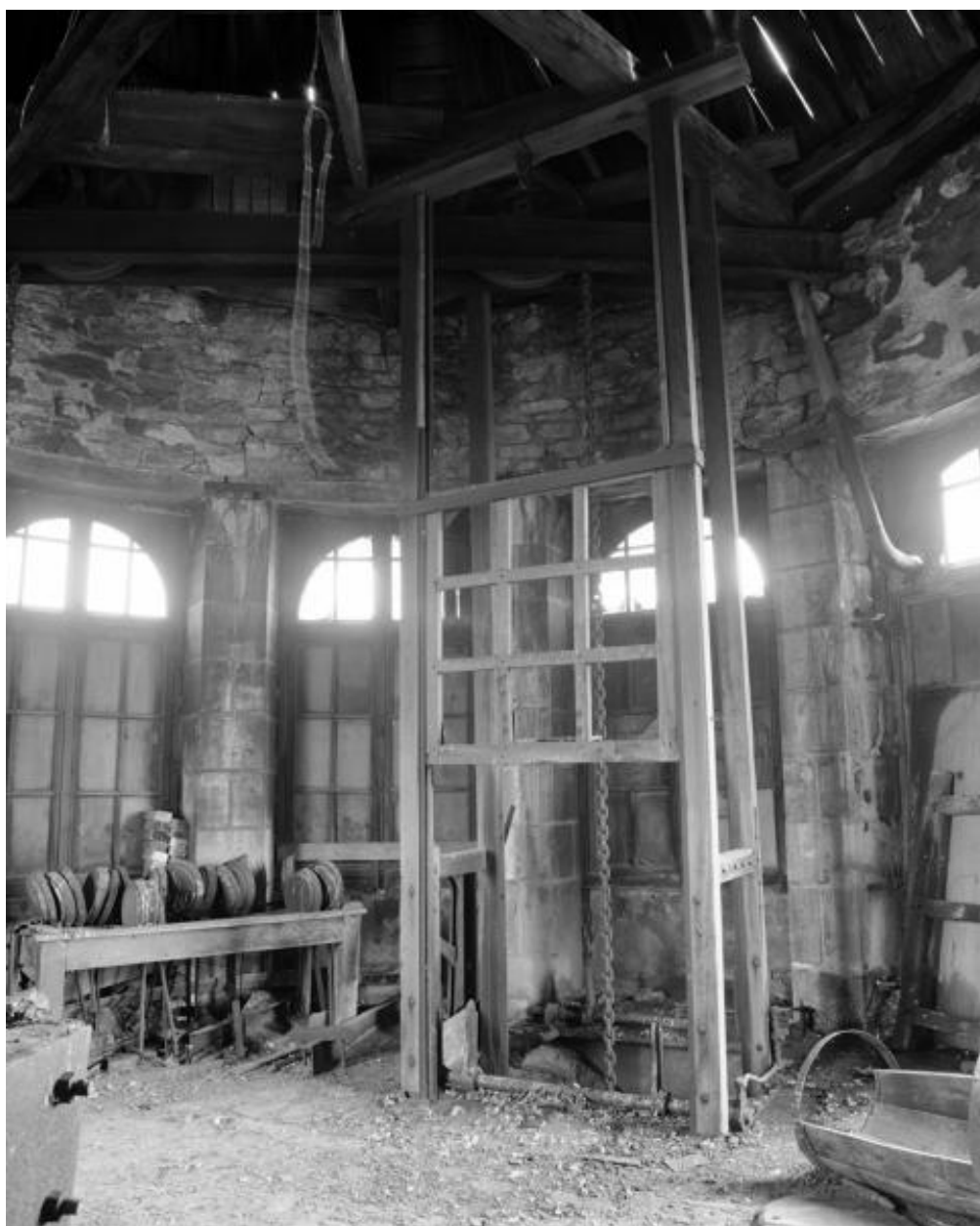
Détail du monte-charge.
