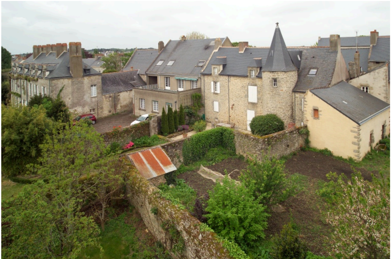
Vues générales des maisons du côté impair de la rue de Bizienne, façades postérieures.
