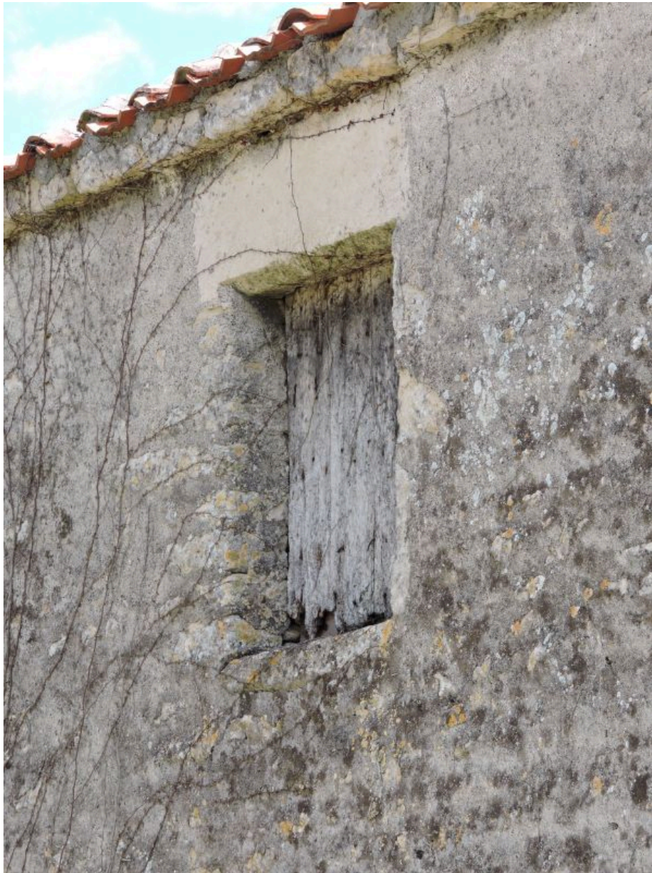
Petite baie à linteau chanfreiné sur les communs.
