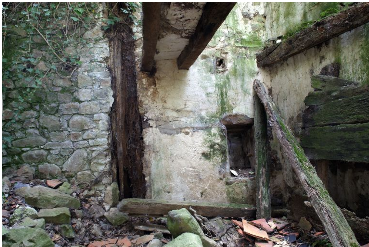
Rez-de-chaussée, pièce nord : le mur est.
