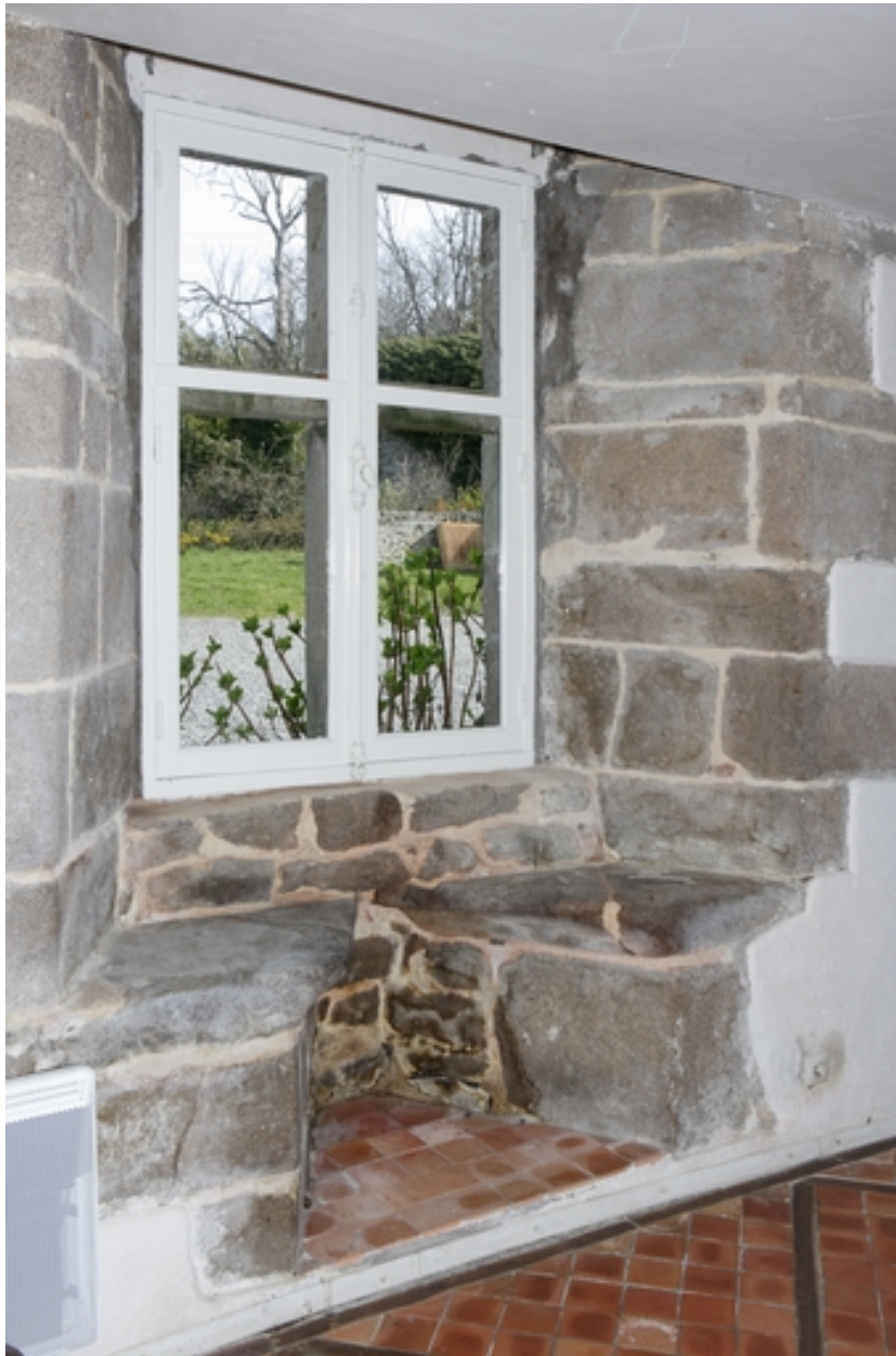
Rez-de-chaussée. Salle basse. Embrasure de la croisée nord.
