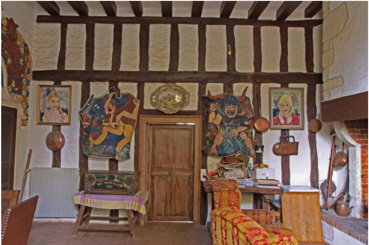
Cloison en pan de bois séparant la salle principale de la chambre.
