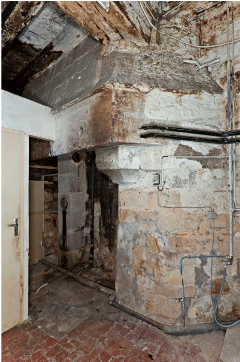
Salle nord, détail : cheminée adossée à la première.
