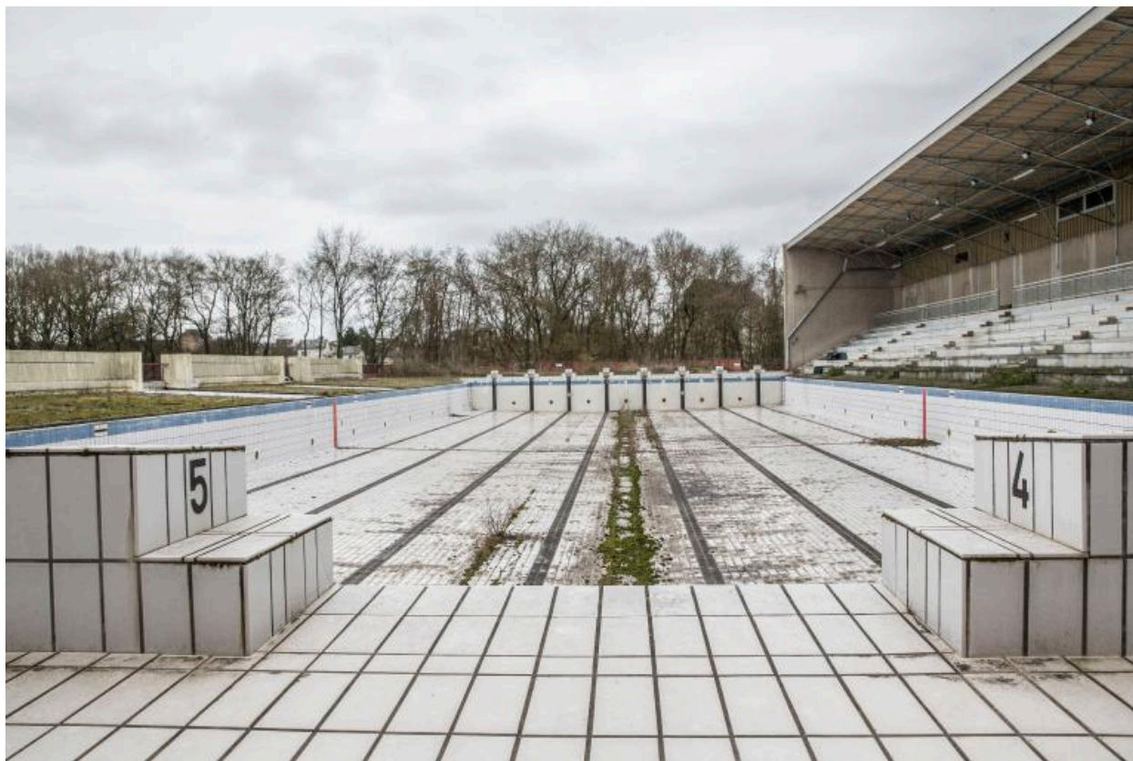
Vue du bassin de 50 mètres.
