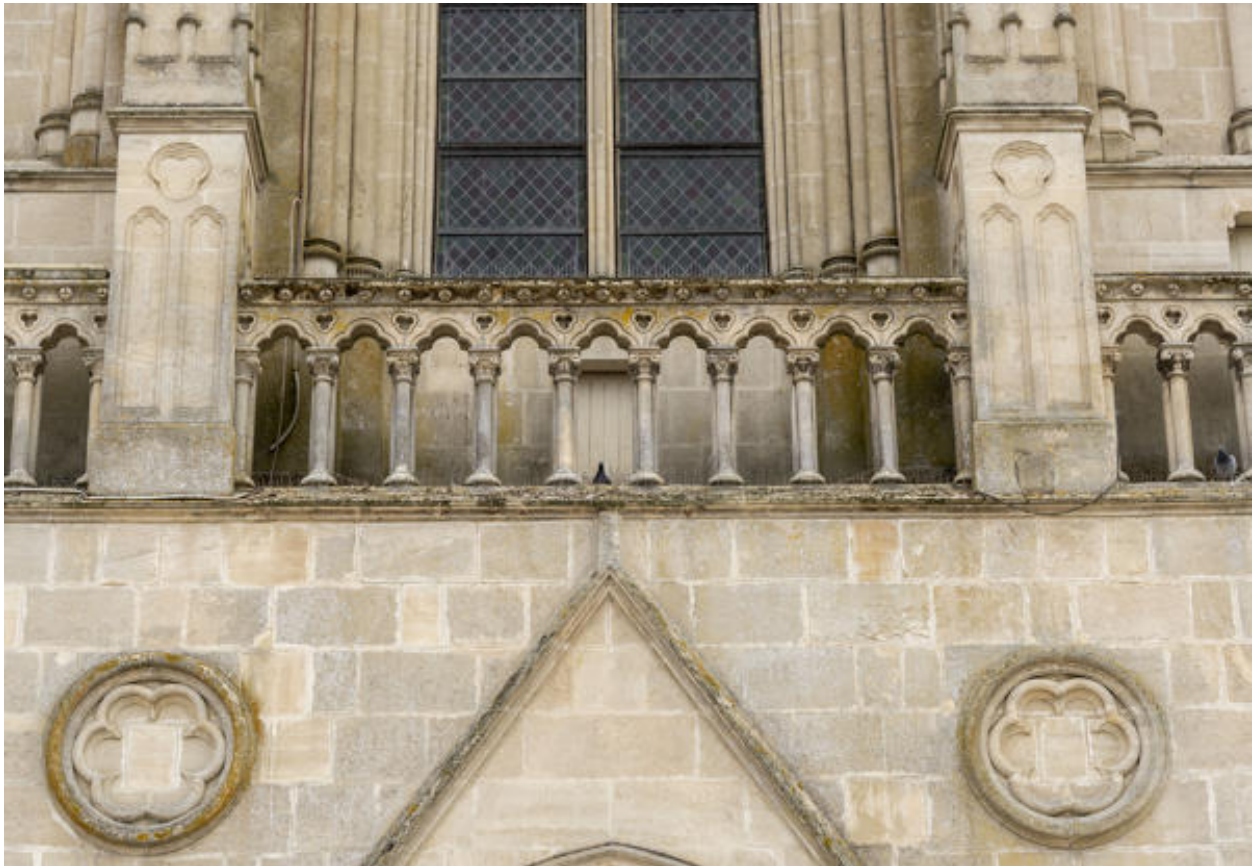
Un détail de l'arcature de la façade occidentale.
