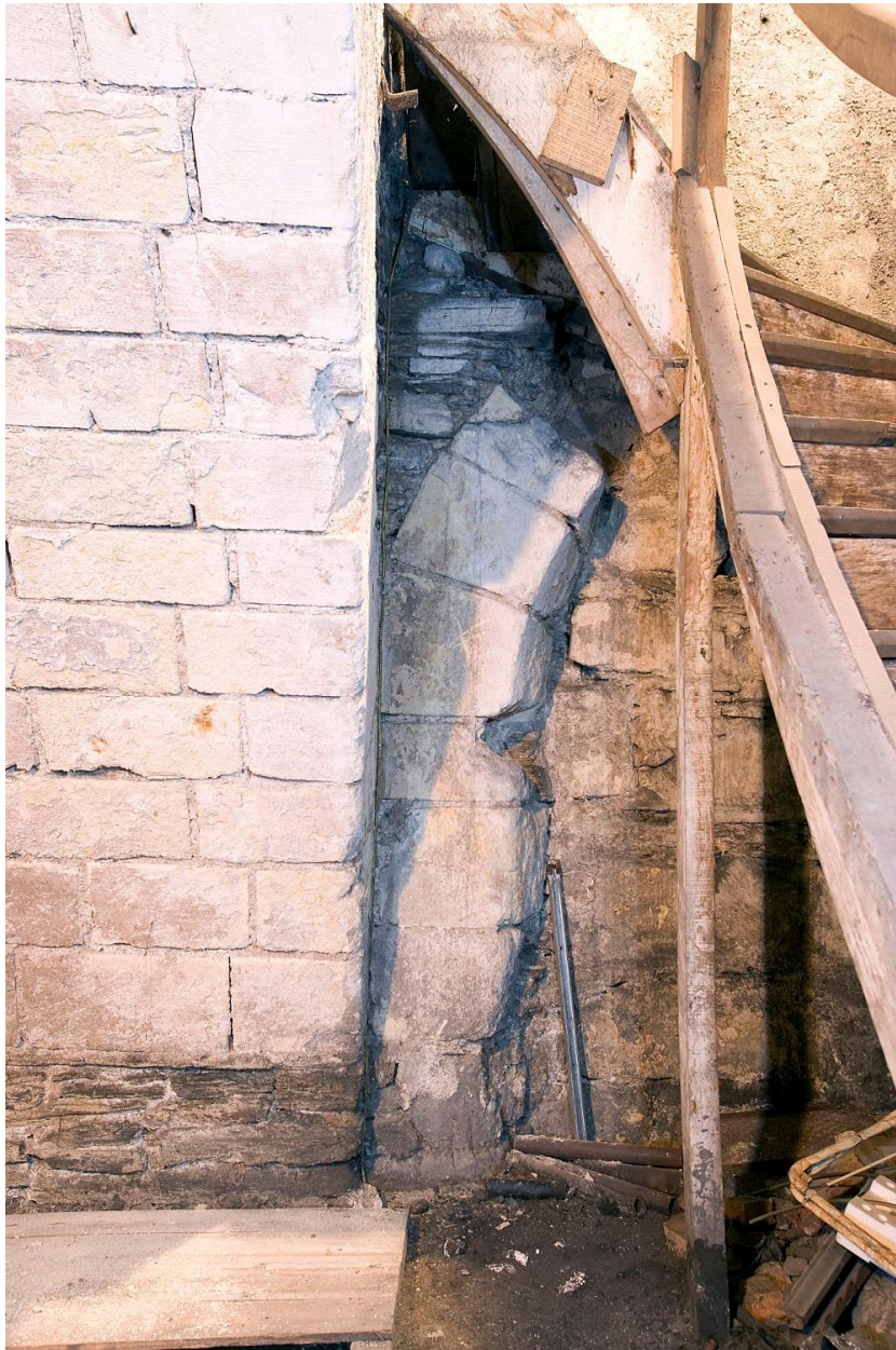
Corps de bâtiment du petit séminaire, sous-sol : cave 2, face postérieure, vestiges d'une porte romane ; à gauche, front d'un arc-diaphragme.
