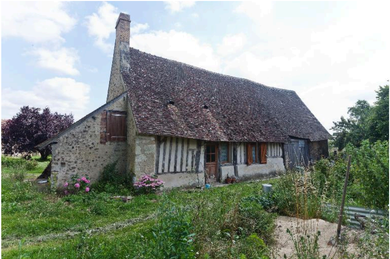
Élévation postérieure du logis de la ferme 1.
