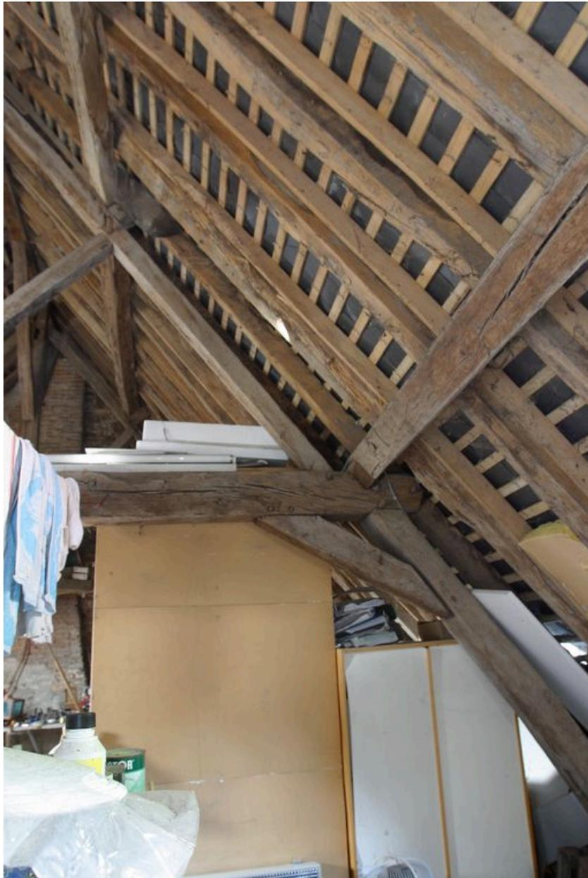
Comble : détail d'assemblage de la charpente
