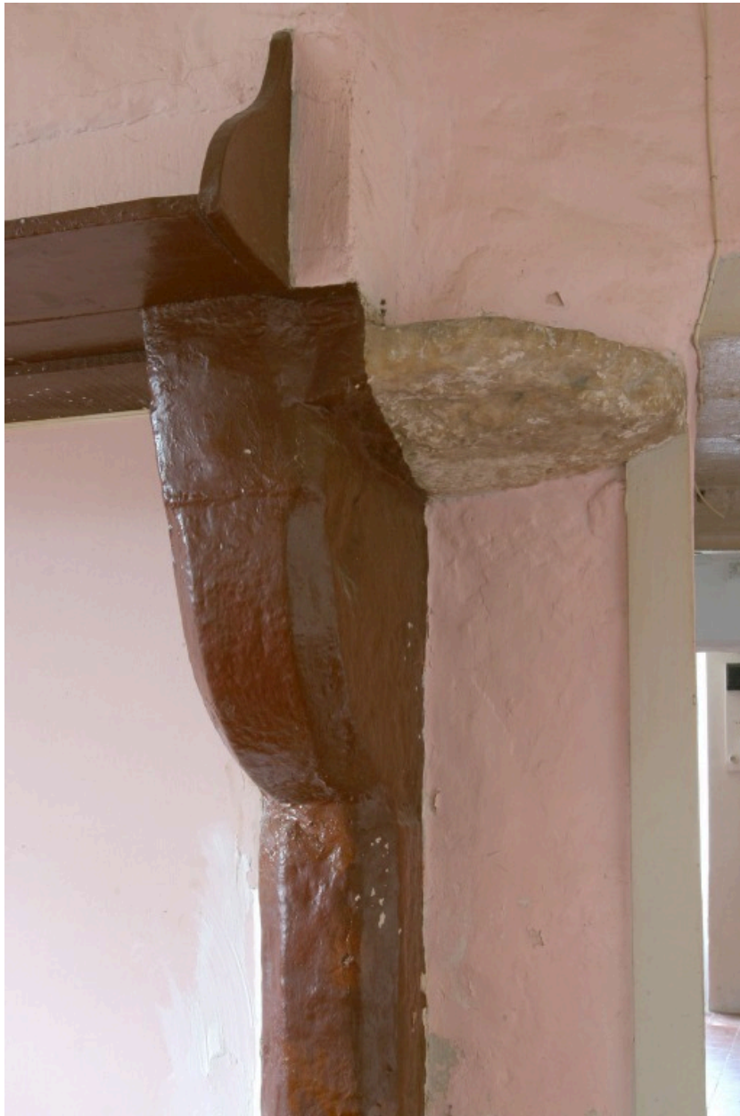
Etage de soubassement. Pièce 2A : le corbeau droit de la cheminée.
