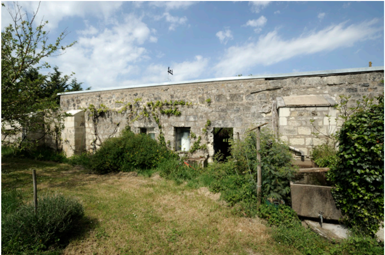
Moulin des Chaffaux : mur sud (extérieur).
