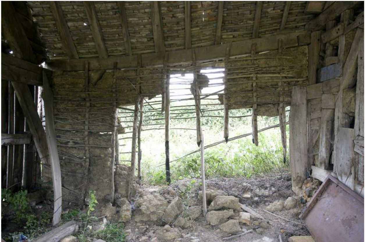
Remise, face interne de l'élévation postérieure.
