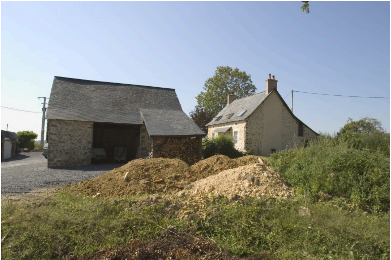
Ancienne ferme est : le remise et le logis vus depuis le nord.
