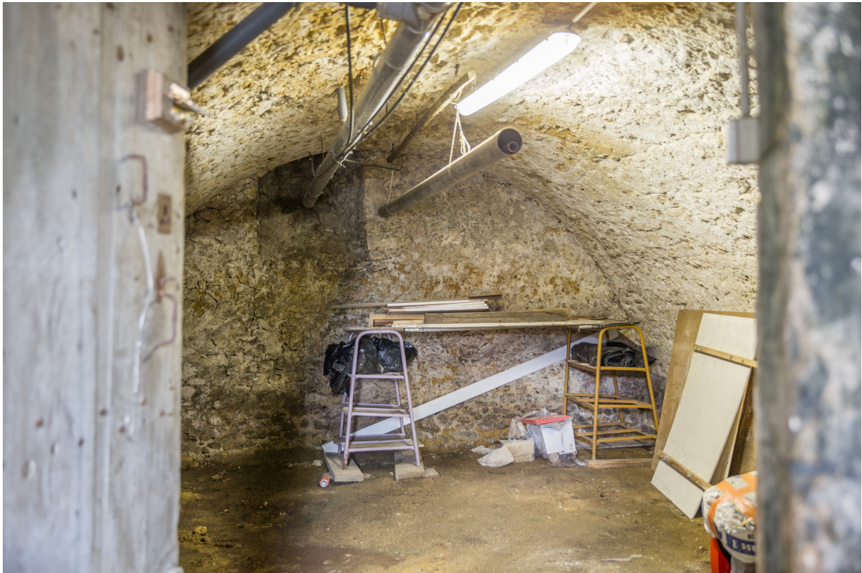
Une des deux caves voûtées.
