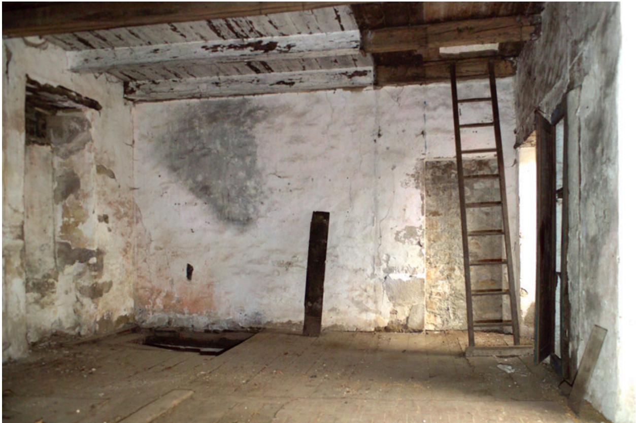
Aile sud, premier étage, pièce orientale, vue vers l'ouest.
