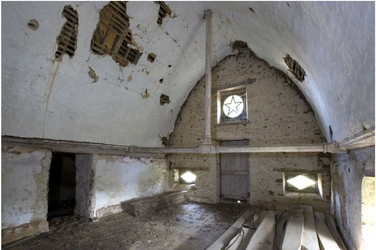
Intérieur de l'ancienne chapelle : la charpente vue depuis l'ouest.
