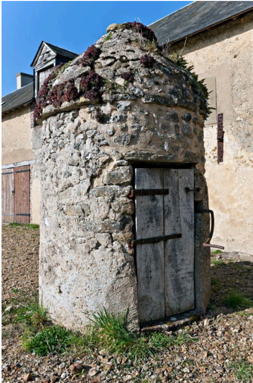
Puits dans la cour, devant les communs.
