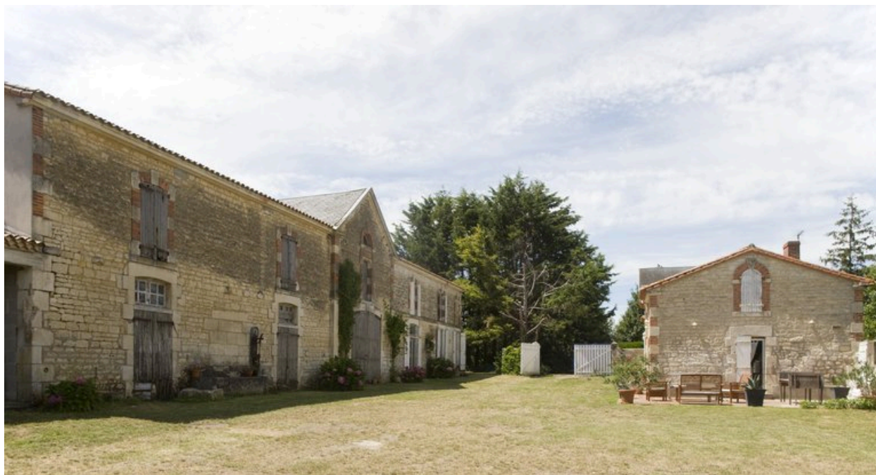
Vue d'ensemble prise de l'est montrant les deux bâtiments.
