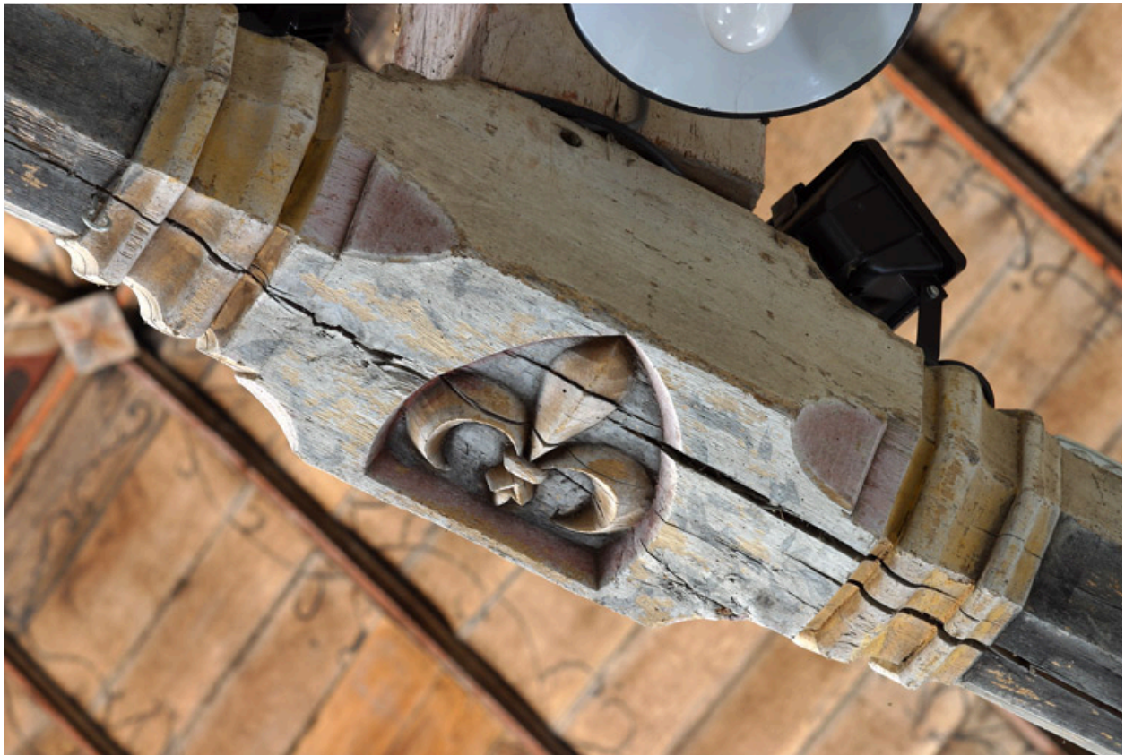
Nef, voûte, première travée, entrant : détail de la fleur de lys.
