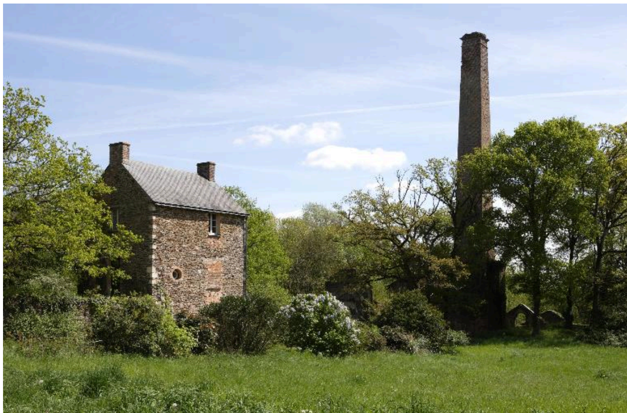
Maison et cheminée de la chaudière.
