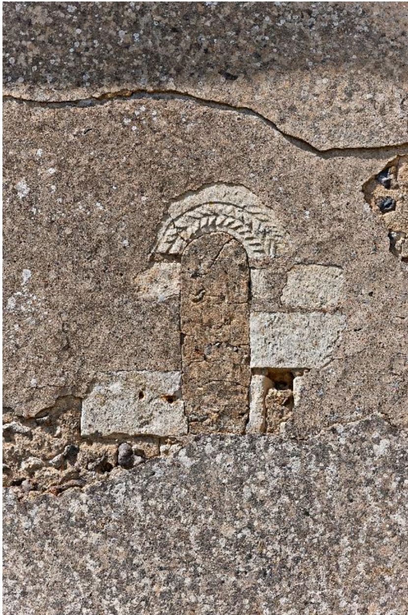
Fenêtre du XIe siècle de l'élévation sud de la nef.
