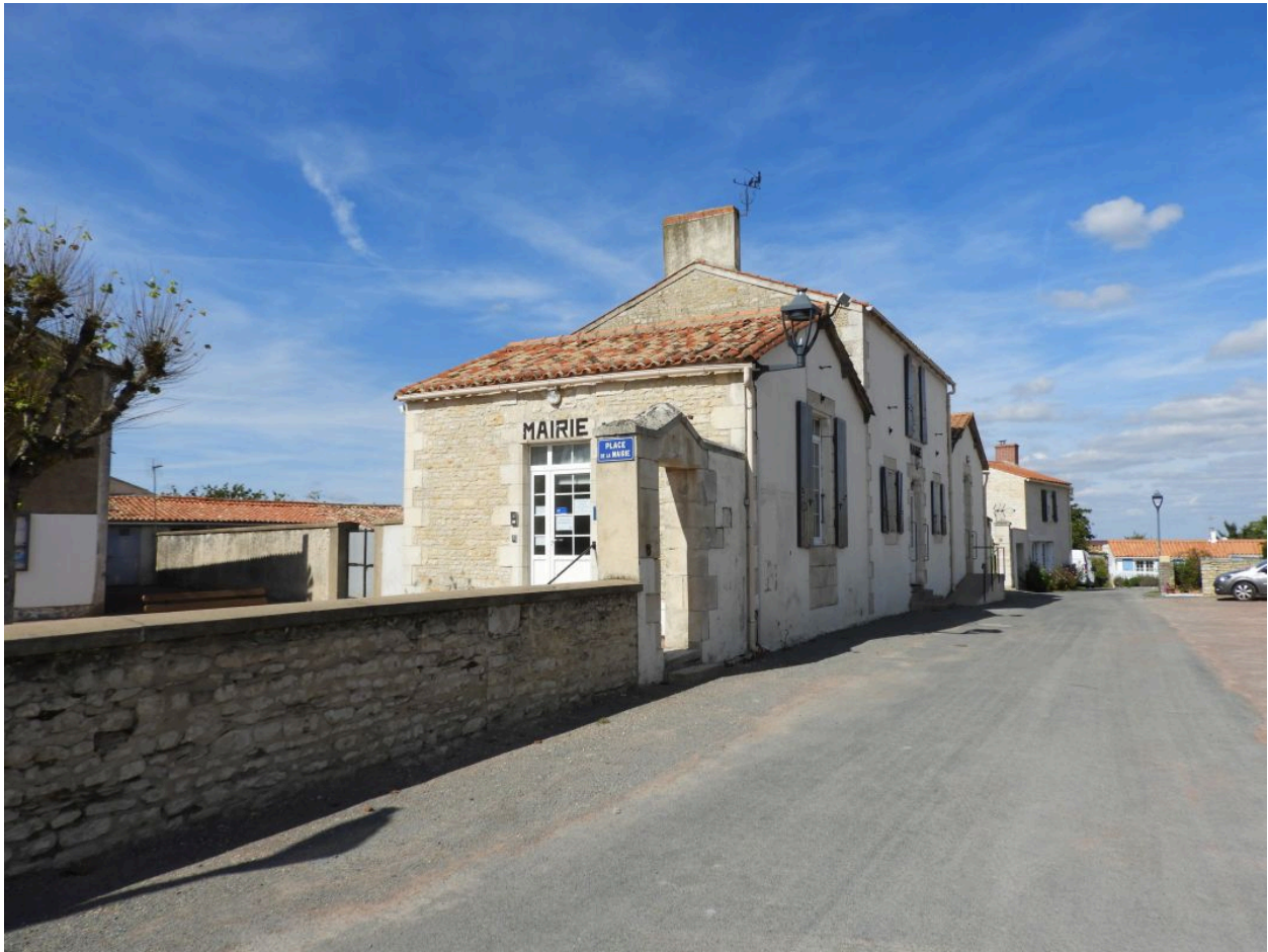
La mairie vue depuis le sud-est.
