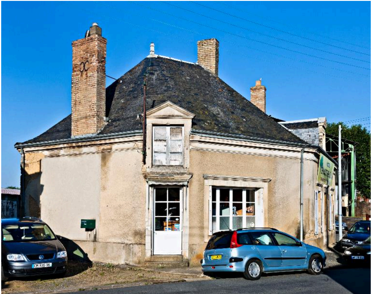
Élévation sur rue de la maison 41.
