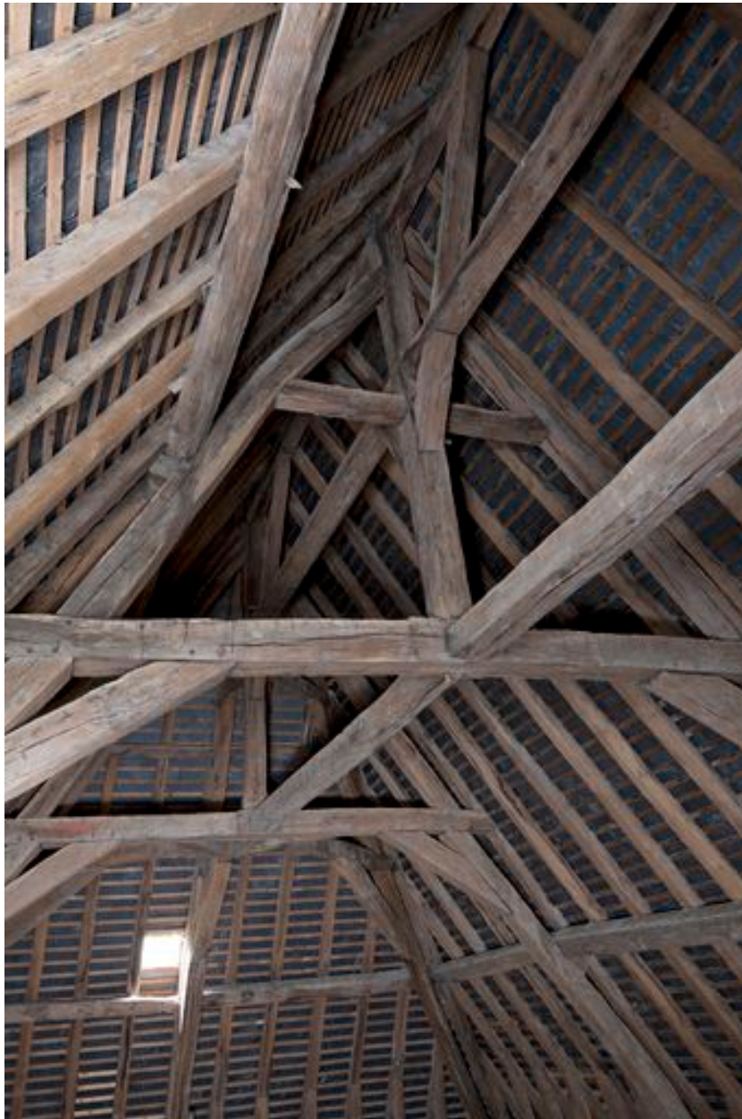
Bâtiment des archives : vue de la charpente.
