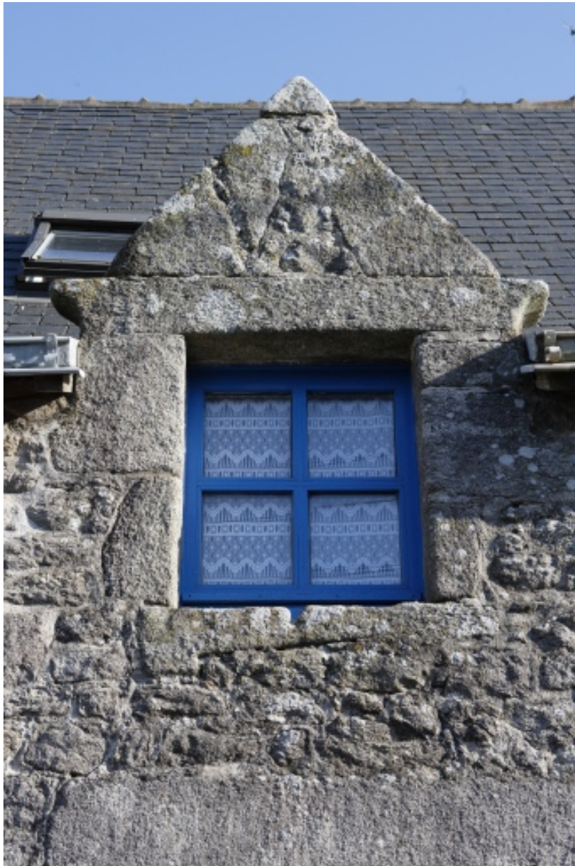
Détail de la lucarne du 3e logement.
