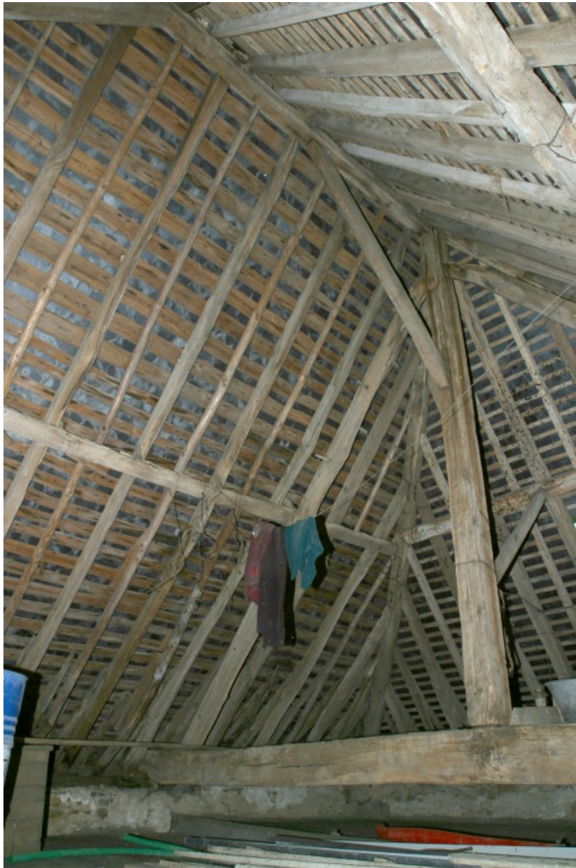
Détail de la charpente : la ferme sud.
