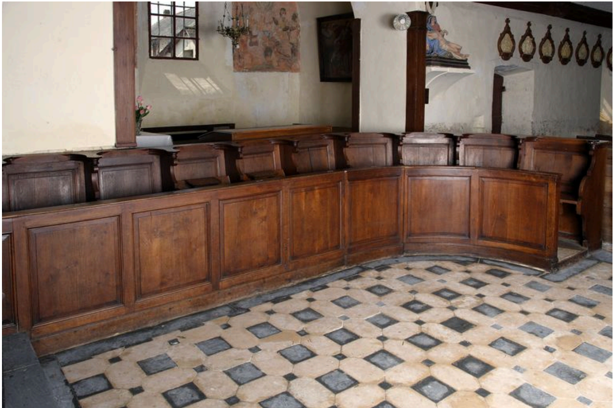
Vue d'ensemble des stalles sud.
