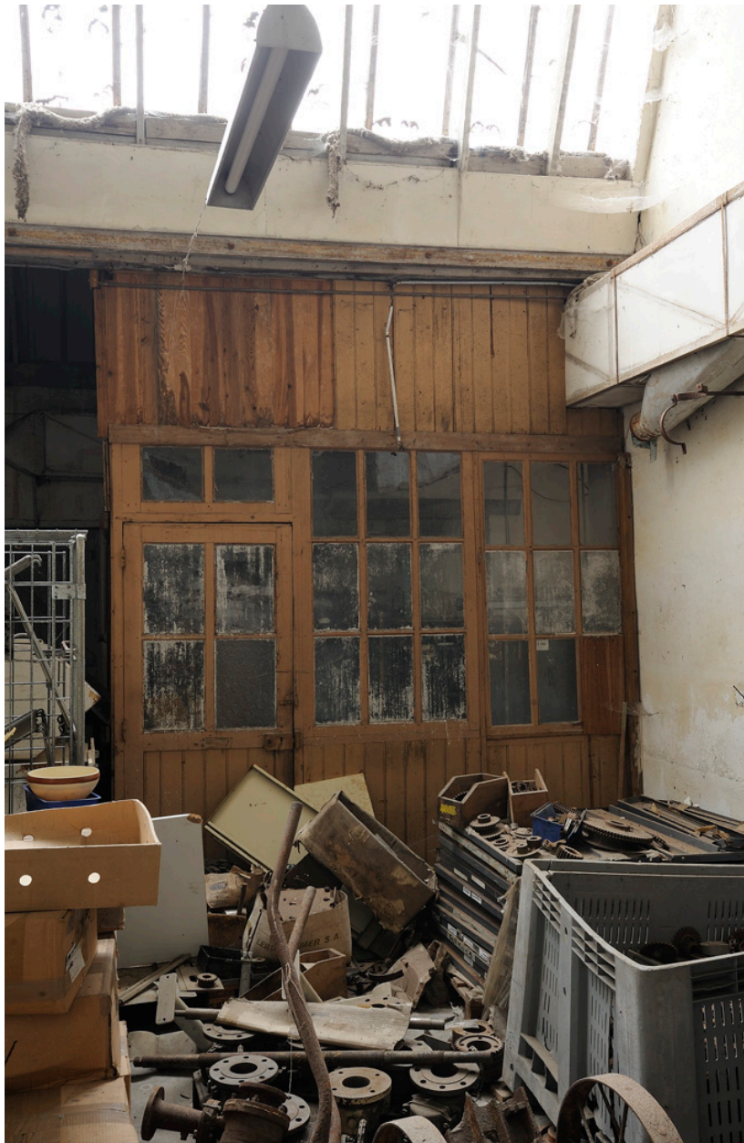
Cabine de contremaître, située dans le plus grand atelier de confection.
