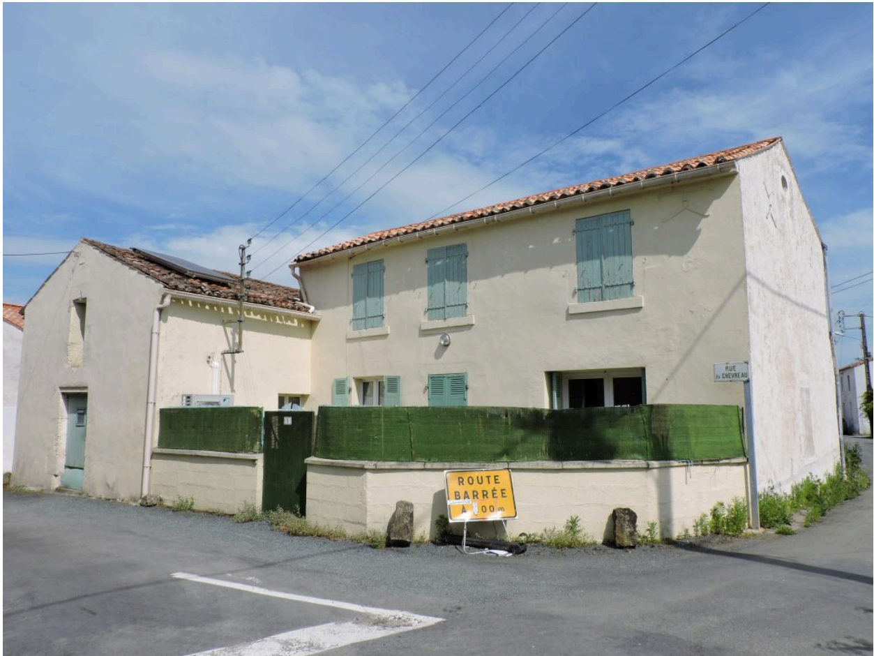
L'ancienne boulangerie vue depuis l'ouest.
