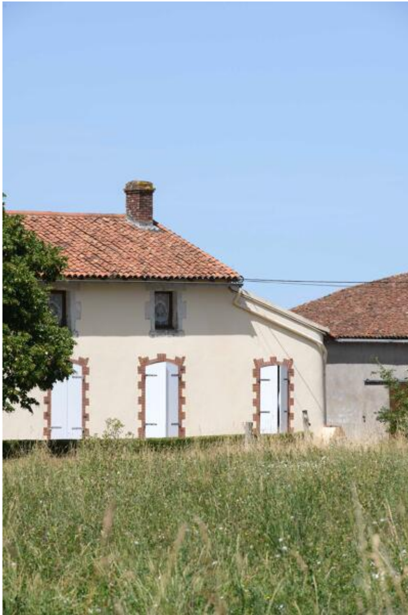
Détail de l'angle arrondi de la partie est du logis des Petites Marottières.
